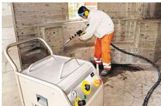
Minus 80 Grad für saubere Kirchenwände: Ein Mitarbeiter reinigt mit der neuen Eis-Technologie den Innenraum der Churer Heiligkreuzkirche.
