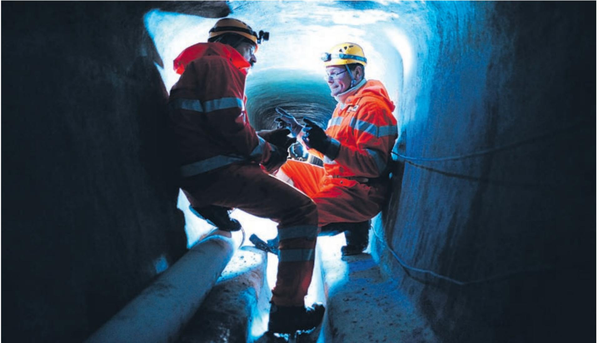
Kanalsanierer arbeiten wie der Zahnarzt: Zuerst wird der Abschnitt trockengelegt, dann der faule Beton weggefräst und am Schluss werden die Löcher mit neuem Verputz aufgefüllt. Bild: Marc Dahinden
